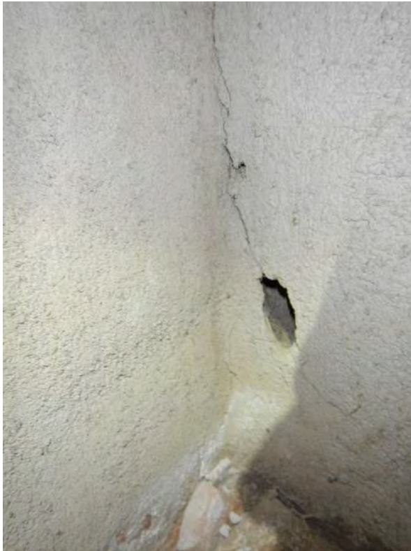
Kuva 15. Rakenneavaus VS1. Väliseinärakenteessa on käytetty huoltotunnelin puolella lastusementilevyeristettä. Eristeestä otettiin näyte mikrobien suoraviljelyyn (näyte 5).
