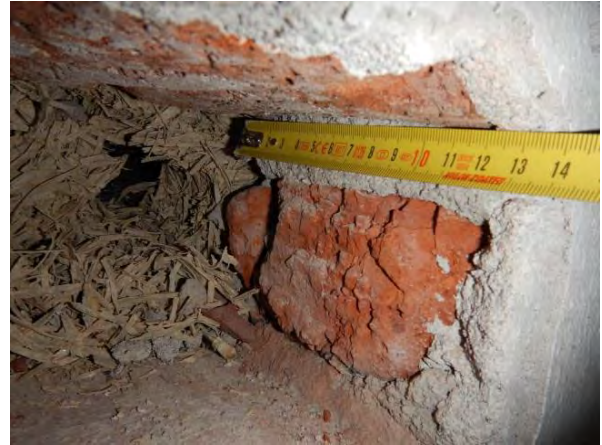
Kuva 6. Rakenneavaus US1. Maanvastaisen ulkoseinän sisäkuoren vahvuus on n. 140 mm.
