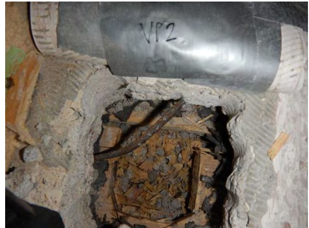
Kuva 13. Rakenneavaus VP2. Välipohjan eristeenä on käytetty kutterilastua. Eristeestä otettiin materiaalinäyte mikrobien suoraviljelyyn (näyte 7).
