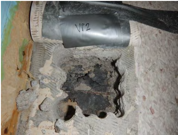
Kuva 12. Rakenneavaus VP2. Välipohjarakenne on kaksoislaattapalkisto. Pintalaatan alla on muottilaudoitus, joka päällä on tervapaperi.
