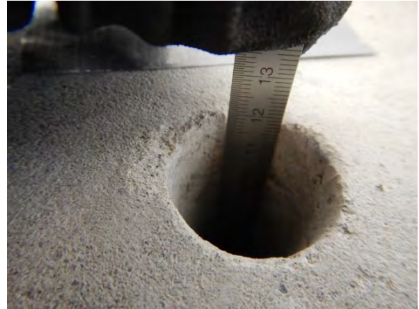
Kuva 2. Rakenneavaus AP1. Alapohjalaatan bitumisively on 120 mm:n syvyydessä.
