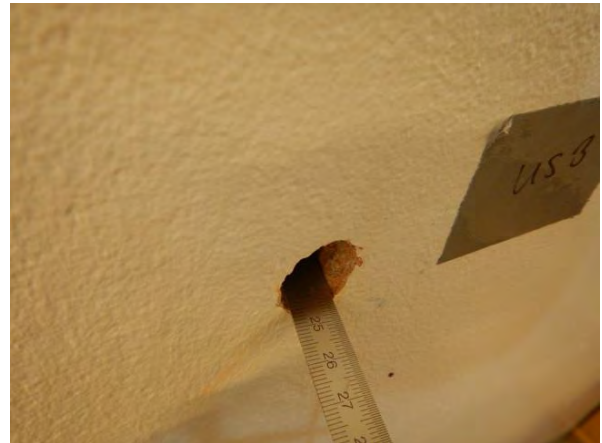
Kuva 8. Rakenneavaukset US3 ja US5. Ulkoseinän sisäkuoren vahvuus on n. 250 mm. Ulkoseinän eristeinä on käytetty mineraalivillaa (näytteet 3 ja 4).
