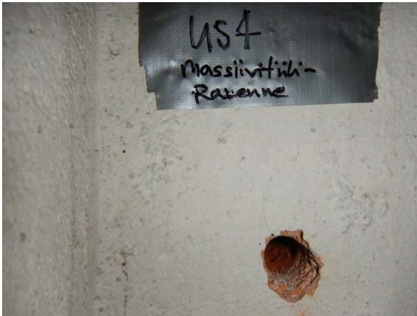
Kuva 9. Rakenneavaukset US4 ja US6. Ullakon portaikon ulkoseinärakenne US4 on massiivitiilirakenne. Ensimmäisen kerroksen ulkoseinärakenne US6 on massiivitiirakenne.
