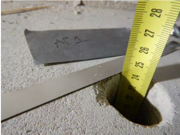
Kuva 1. Rakenneavaus AP1. Maanvastaisen alapohjalaatan vahvuus on rakenneavauskohdalla 240 mm.
