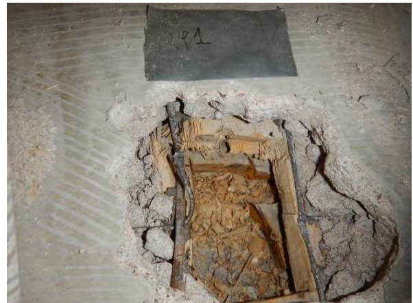
Kuva 11. Rakenneavaus VP1. Välipohjan eristeenä on käytetty kutterilastua. Eristeestä otettiin materiaalinäyte mikrobien suoraviljelyyn (näyte 6).
